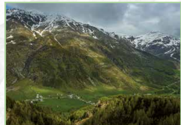
▲ 7 Frana del Monte Mater. Deformazione gravitativa profonda (DGPV) e frana complessa.
