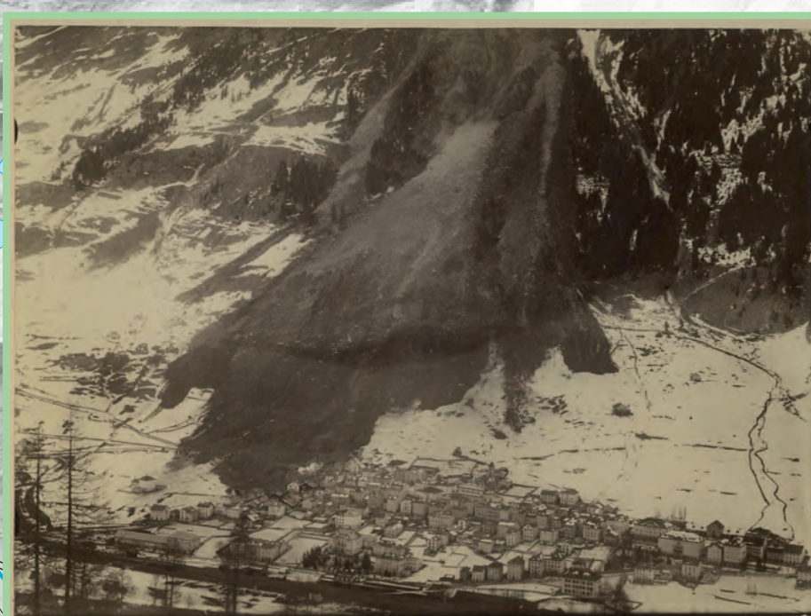
▲ 18 Frana del Sasso Rosso. Crollo 1898.
