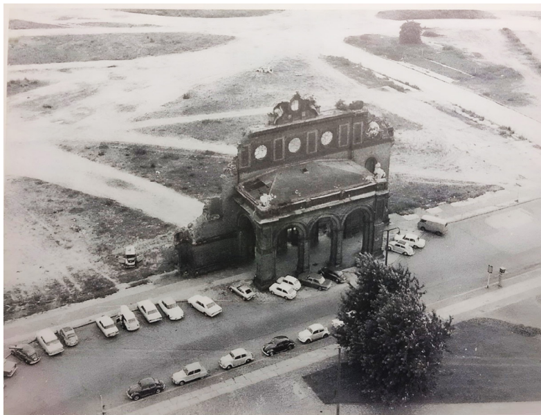
Fig. 7 Veduta aerea dello Anhalter Bahnhof dall'Hotel Excelsior antistante. Lo scatto risale al giugno 1969 e mostra ciò che ne resta all'epoca in cui Celan visitò Berlino due anni prima. Come si vede, solo il porticato di ingresso è sopravvissuto all'opera di demolizione della stazione, dopo che fu gravemente danneggiata da bombardamenti e dai combattimenti urbani. Ad oggi, le rovine qui ritratte sono tutto ciò che resta della struttura architettonica complessiva. Fonte: Gottwaldt 1994: 4. Licenza: CC BY-ND.
