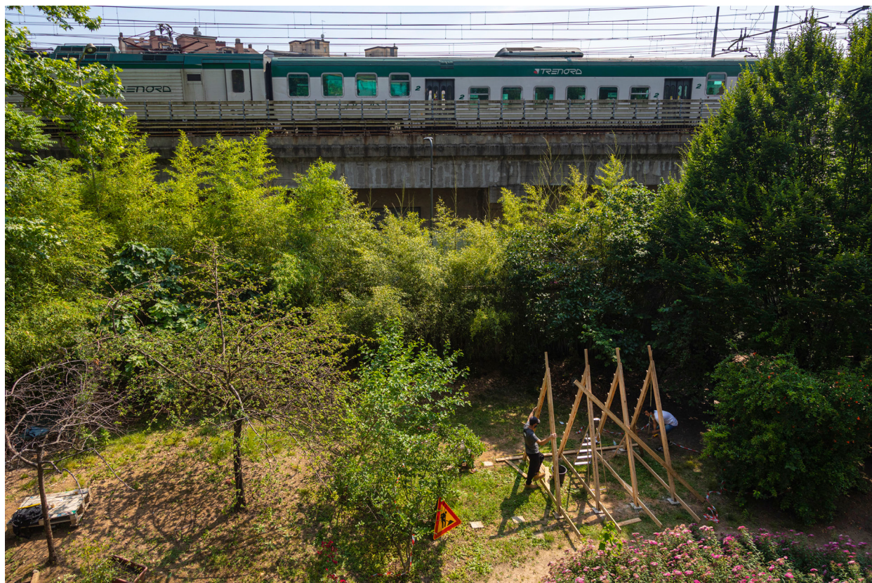
Azione di autocostruzione nel giardino. Comin Cooperativa Solidarietà Sociale
