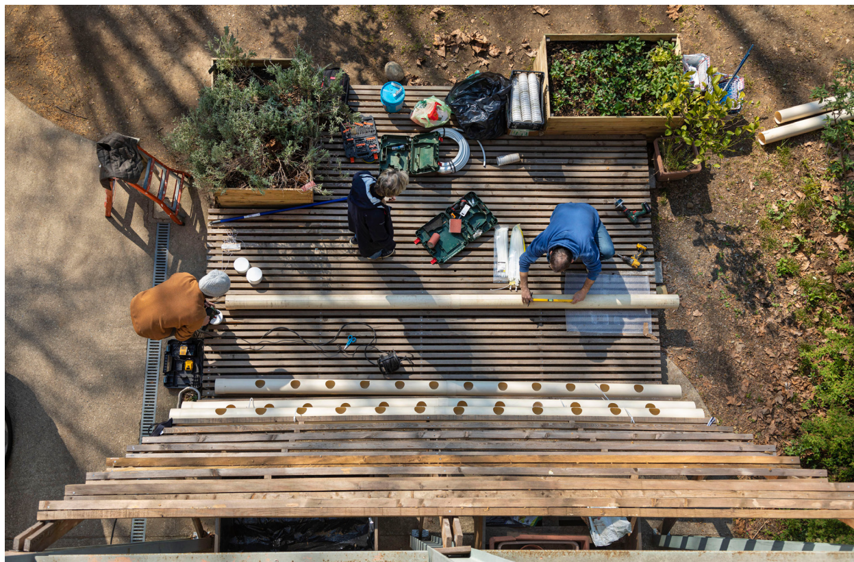
Autocostruzione parete-pergola per creare l'impianto di idroponica verticale. Comin Cooperativa Solidarietà Sociale
