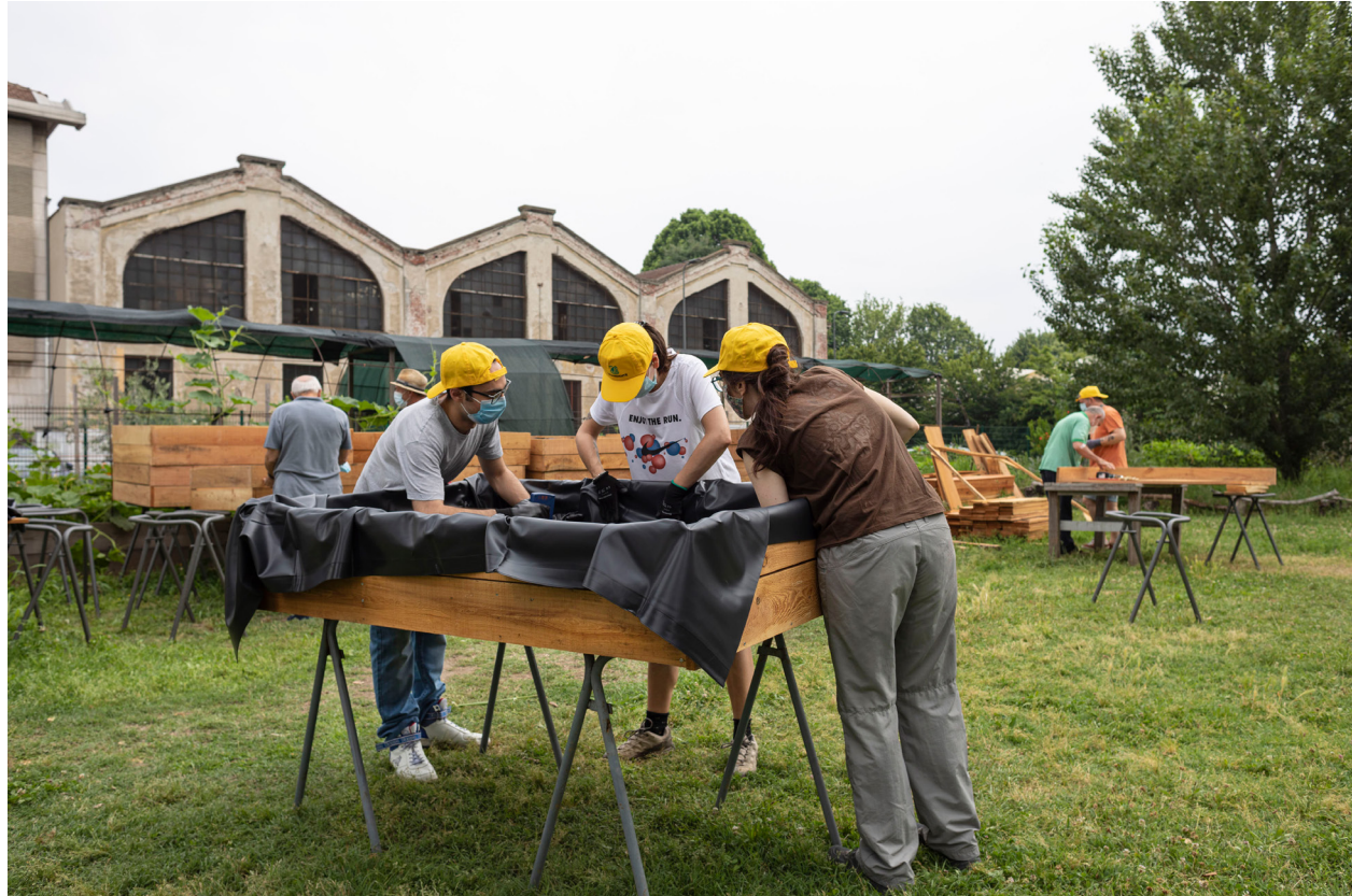
Autocostruzione delle vasche di droponica. Orti di Via Padova Circolo Legambiente Milano
