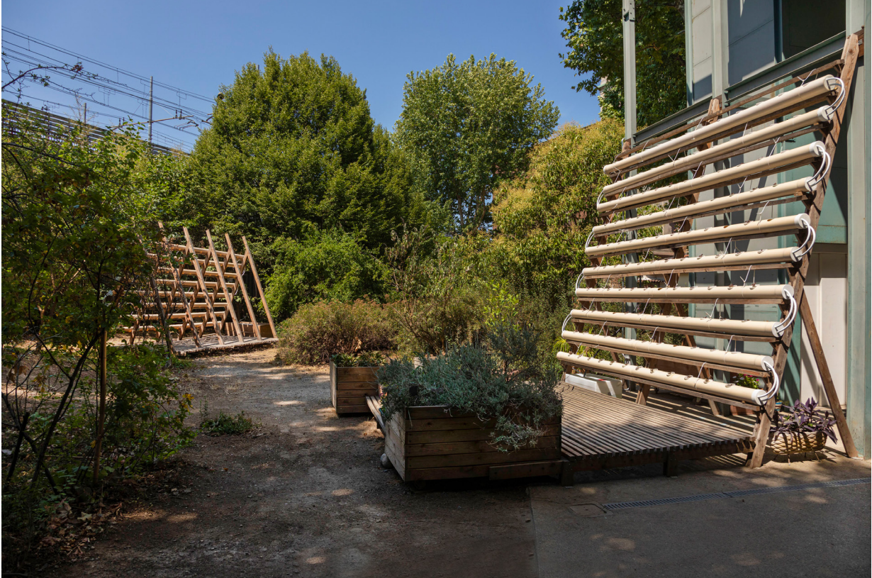
Vista pareti-pergole con impianti di idroponica verticale. Comin Cooperativa Solidarietà Sociale
