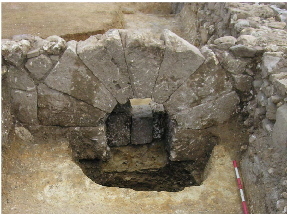
1. Dettaglio dell'arco a tutto sesto in conci regolari e imboccatura della campana visti da Nord.
